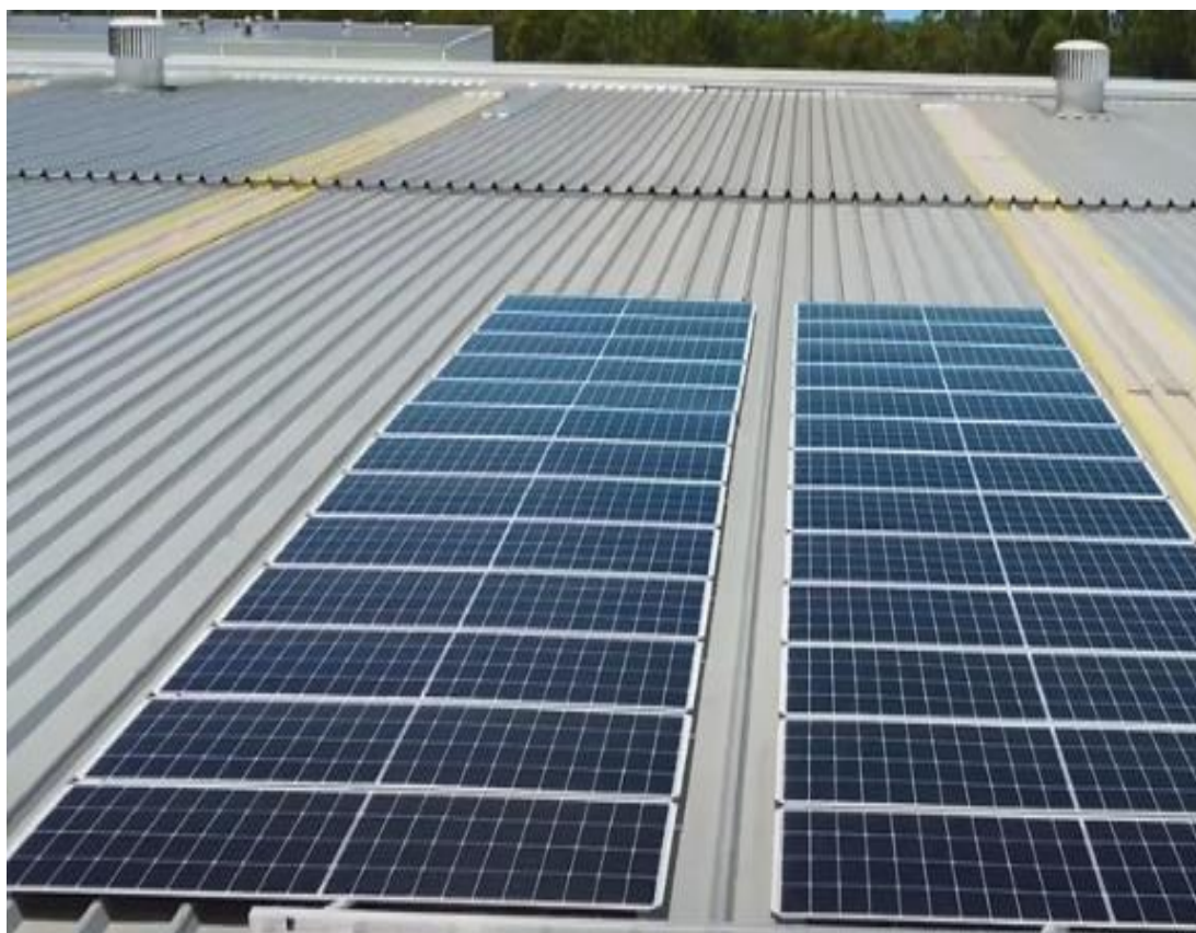
Figura 1 Linha Galaxy instalada sobre telhado frágil. Fonte: GoodWe.
